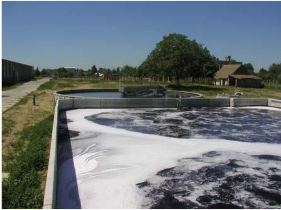
Слика 8.1. Таложник за пречистување на отпадните води
